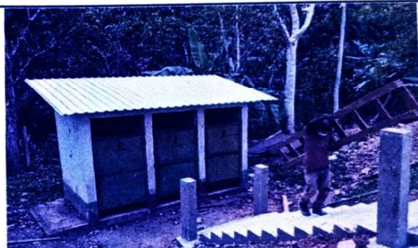
Foto 4: de esta forma se realizaron los trabajos de mantenimiento de los sanitarios.
