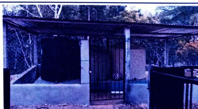
Foto 6: se observa la colocacion de malla para cerco para proteger las cisternas de agua.
