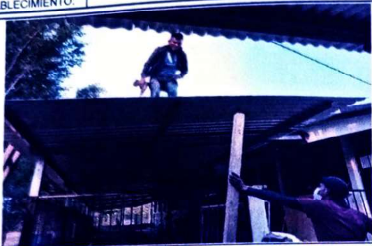
Foto 1: estaba en proceso la sustitucion del techo de laminas acanaladas a laminas troqueladas
