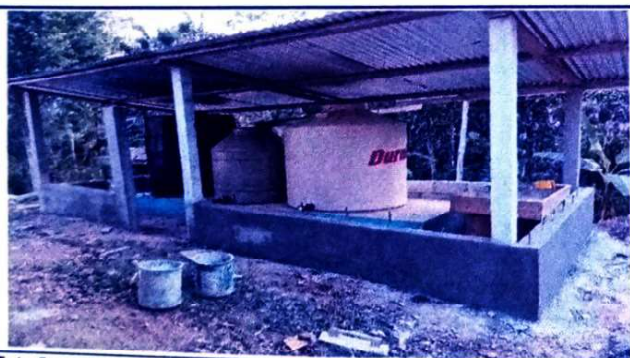
Foto 5: se observa la circulacion con tres hiladas de block del lugar de los cisternas de agua.
